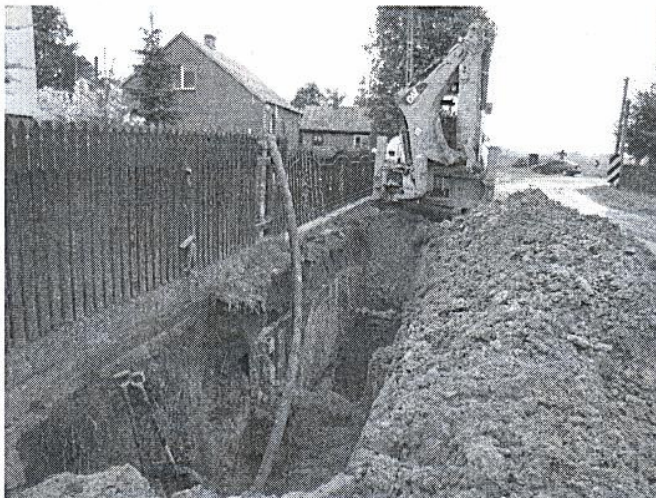
5 Wykop pod kanalizację grawitacyjną i tłoczną, m. Puciska 6. Studzienka na kanale grawitacyjnym w m. Puciska
